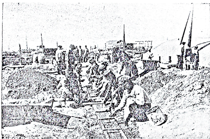
Канализация г. Тулы—1929 г (Фот. газ «Коммунар»).
